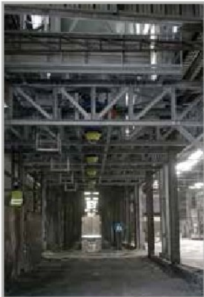
SILOS SU STRUTTURA CON SCARICATORE TELESCOPICO PER CARICO AUTOBOTTE SILOS WITH DISCHARGE SCREW FOR LOADING TANK TRUCKS
