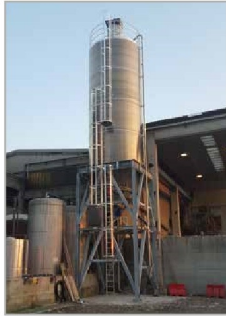
SILOS CON STRUTTURA SILOS WITH STRUCTURE
